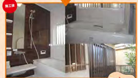
システムバスにリフォームして快適に生活していただけるのですが、冬場でも安心して入浴していただけるよう窓断熱を提案いたしました。マドリモの良いところは、外壁補修を行う工事より工期が短縮でき、元々あった面格子を再利用することによって防犯性を損わず施工可能などです。
